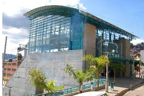
Station du transport par câble de Medellín – Fond photographique SYSTRA
