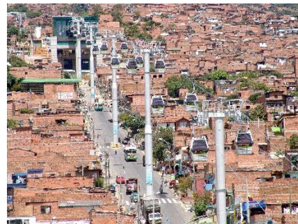
Exemple de Medellín – Fond photographique SYSTRA
