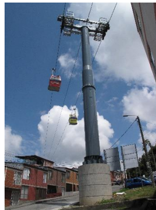
Pilône du transport par câble de Manizales – Fond photographique SYSTRA
