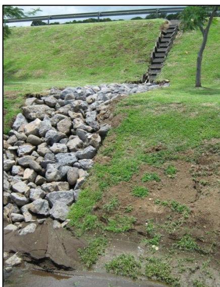
Figure 23 Protection en enrochement
