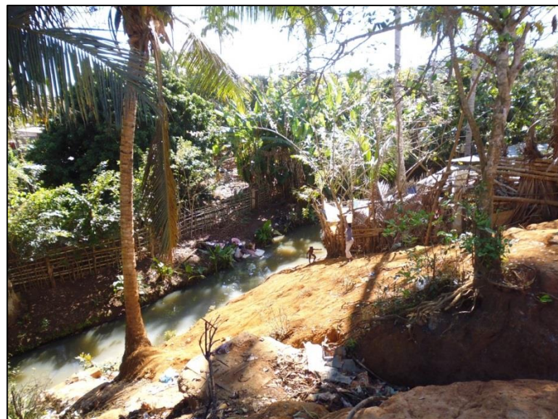
Figure 6 : Exutoire d'un réseau d'évacuation des eaux pluviale + construction en berge (Combani)
