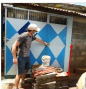
Laisses de crue sur une habitation rue M Bonifati, Sources : Rapport BRGM 2021
