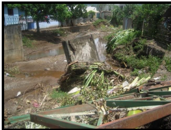
Photo de laisse de crue après le 24 janvier 2008 à Bandréle sur la rivière Dangoni. DEAL Mayotte
