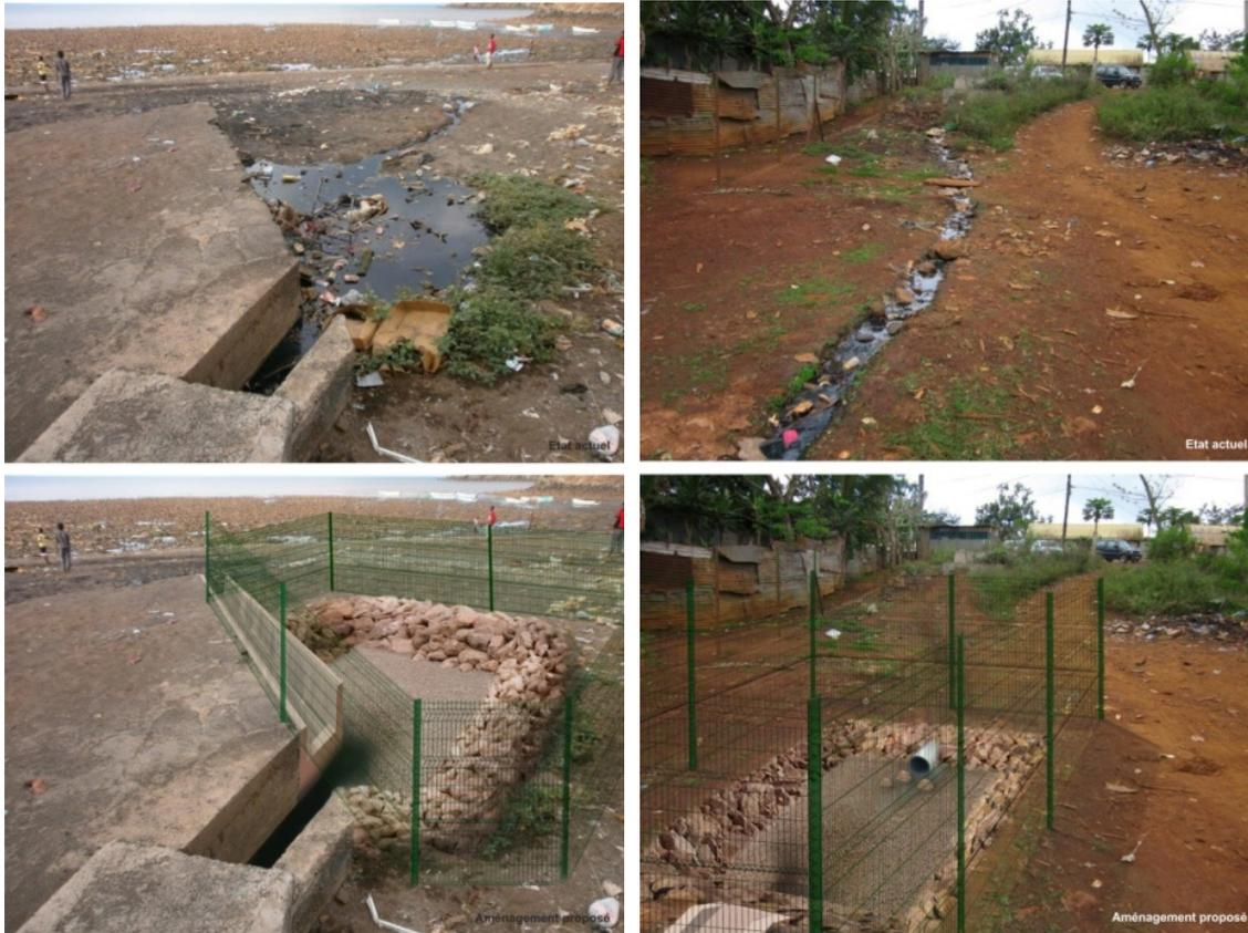
Figure 4 : Exemple de lits d'infiltration
