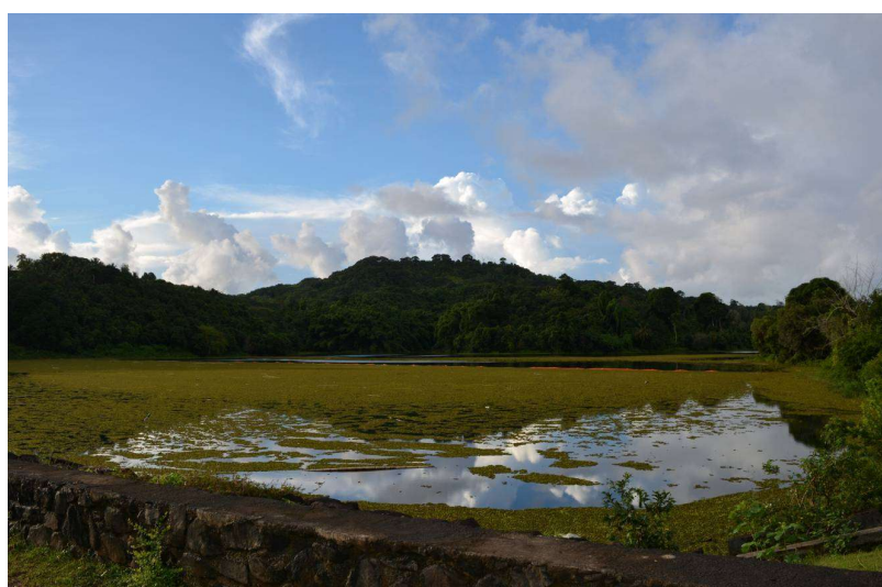
Figure 13 : Retenue collinaire de Combani.
