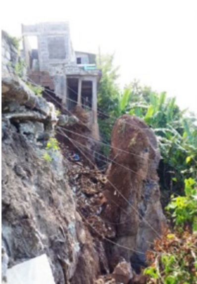
Réalisation de travaux d'urgence, vue du talus Majicavo
