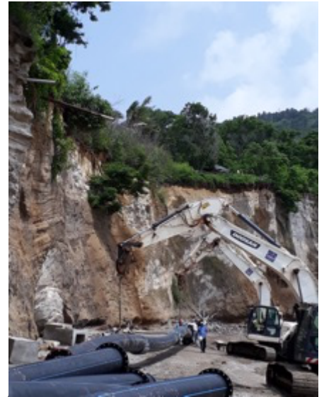
Travaux usine dessalement
