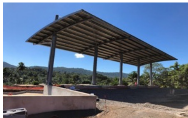
Travaux Quai de transfert de Kahani
