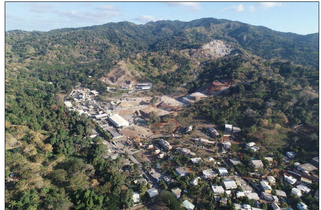
Photo 10 : Vue aérienne actuelle du site du projet
