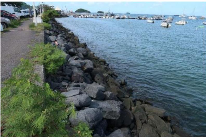
Figure 90: Enrochements au niveau du littoral du port de plaisance
